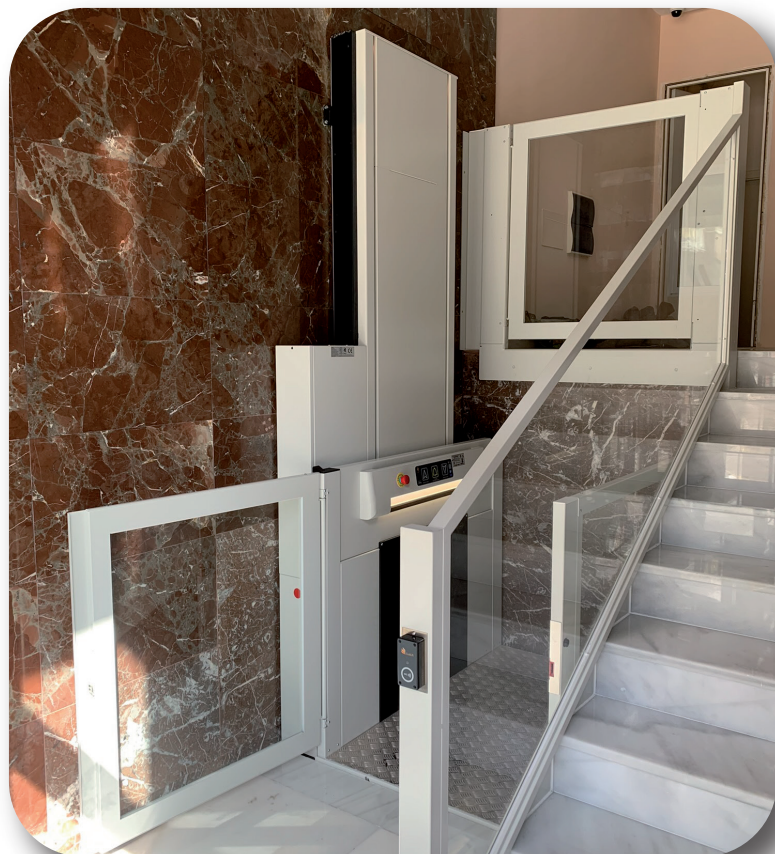
Pulsadores de abordaje sensitivos y NFC en piso
